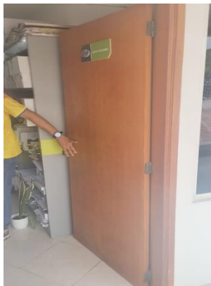
Ilustración 12 Of. Notificaciones Libre de obstáculos detrás de la puerta (Corregido)-Espacio maniobra 50cm (Persiste incumplimiento)
