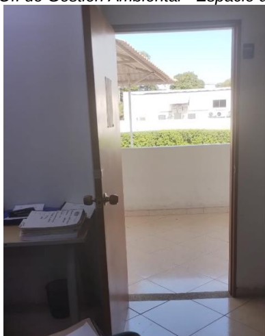
Ilustración 10 Of. Financiera Espacio de maniobra 50 cm y obstrucción en la parte de atrás de la puerta (Persiste incumplimiento)
