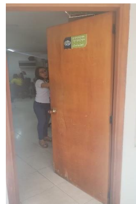
Ilustración 10 Of. Financiera Espacio de maniobra 50 cm y obstrucción en la parte de atrás de la puerta (Persiste incumplimiento)
