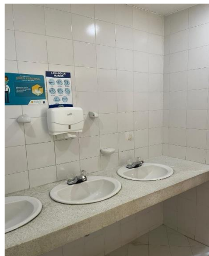
Ilustración 8 Of. Educación Ambiental -Espacio de maniobra (remodelada, cuenta con espacio de maniobra de 1.50 m)
