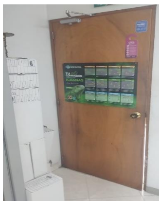
Ilustración 10 Of. Financiera Espacio de maniobra 50 cm y obstrucción en la parte de atrás de la puerta (Persiste incumplimiento)
